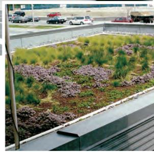
市民對於消防隊的第一印象就是火場救人。不過事實上，消防隊除了救火，他們也在各種地震、水災等場合出現，現在消防隊還要以身作則，帶頭節省能源，保護環境。這棟列治文最新的消防局建築，就採用了多項環保設計。其中，屋頂的太陽能板，將負責把通過該位置的水源加熱，供應消防隊熱水使用。覆蓋在建築頂上的植物，有助降低建築本身溫度，植物本身也將吸引蝴蝶蜜蜂等生物，在建築周圍創造一個富有活力的小型生態區。環保集水系統，則是將屋頂植物多餘的水分，引導到建築旁的一個銀色集水桶，用來沖廁所及洗車。這棟建築還埋設多根深入地底的熱管，只要讓水通過這些管子，深入地底再出來，就足夠提供消防隊所需熱水，及冬天的地熱暖氣。建築內部，不僅採用省電燈泡，還裝設自動感應開關，該感應開關可以自動偵測房間裏面是不是有人，然後依照預設程式，自動開關。此外，建築的窗戶、屋頂設計，全部經過對流、隔熱考量，內部隔間也沒有完全封閉至天花板上，夏天只要把窗戶全部打開，不用冷氣也可以感覺清涼。
