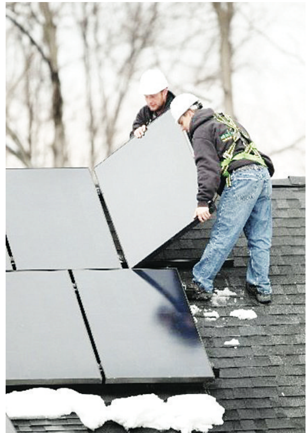
安裝太陽能面板的屋頂必須經過改造，增加其承受負荷的能力。（網絡圖片）
